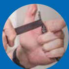
Posa dei cavi
